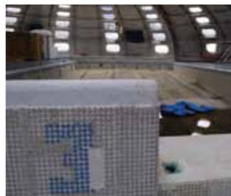
La remise en état de la piscine n'est pas envisageable. Son avenir sera décidé avec les Marquettois
